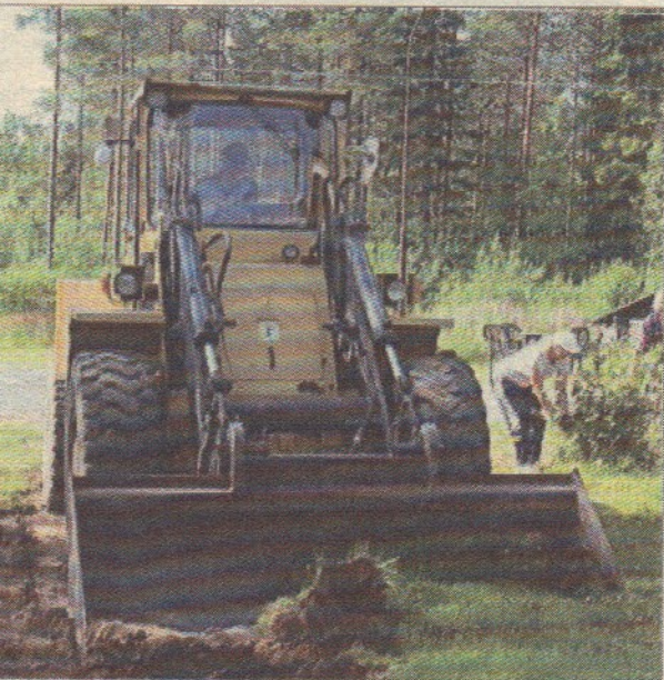
Först schaktar Olle Harila med traktorn bort en del av gräsmattan.
